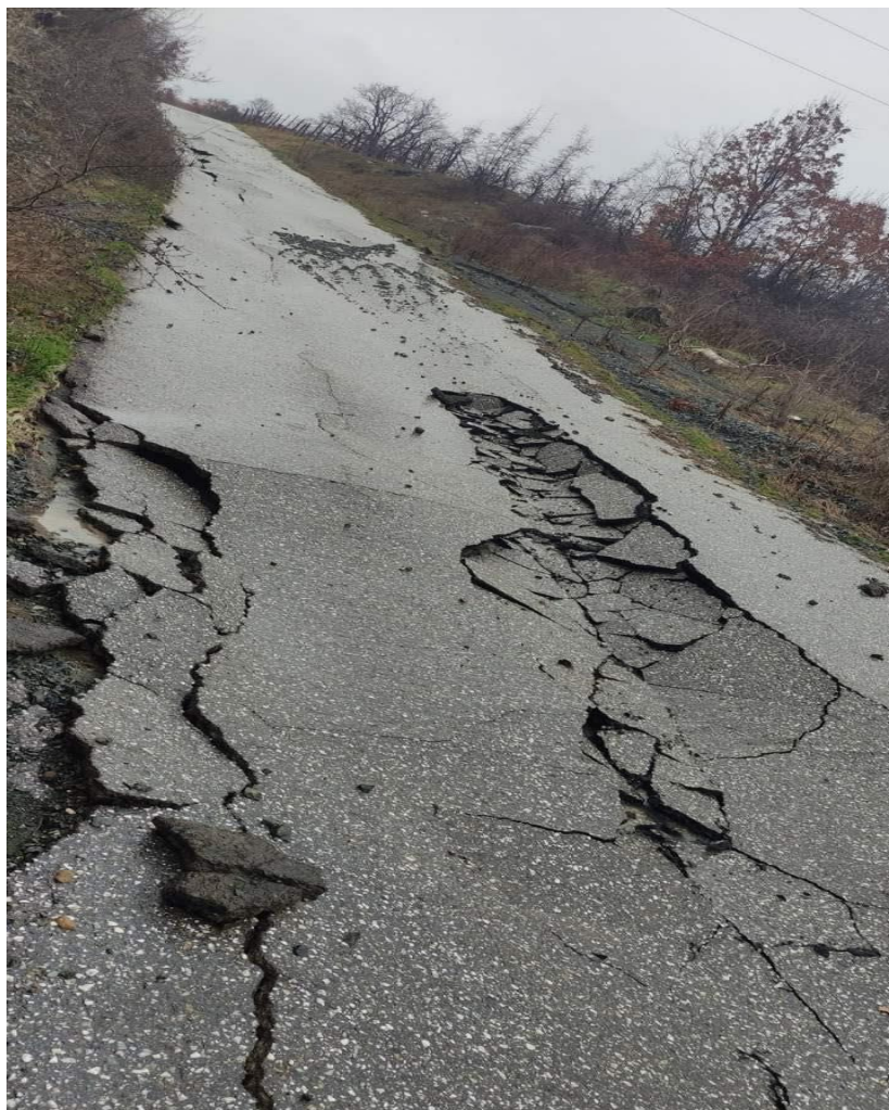
ΦΩΤ. 6 (ΒΡΥΤΤΑ / ΑΠΟΚΑΤΑΣΤΑΣΗ ΟΔΟΣΤΡΩΣΙΑΣ – ΑΣΦΑΛΤΟΤΑΠΗΤΑ)
