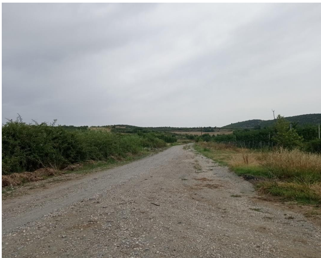
ΦΩΤ. 5 (ΡΙΖΑΡΙ / ΑΠΟΚΑΤΑΣΤΑΣΗ ΟΔΟΣΤΡΩΣΙΑΣ – ΑΓΡΟΚΤΗΜΑ ΡΙΖΑΡΙΟΥ)
