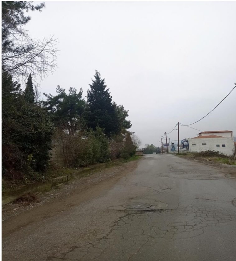
ΦΩΤ. 3 (ΕΔΕΣΣΑ / ΑΠΟΚΑΤΑΣΤΑΣΗ ΑΣΦΑΛΤΟΤΑΠΗΤΑ ΠΕΡΙΟΧΗΣ ΚΟΙΜΗΤΗΡΙΩΝ)
