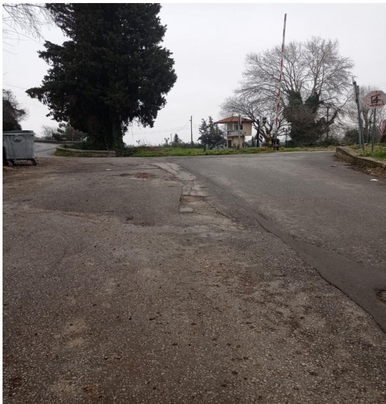
ΦΩΤ. 4 (ΕΔΕΣΣΑ / ΑΠΟΚΑΤΑΣΤΑΣΗ ΑΣΦΑΛΤΟΤΑΠΗΤΑ ΠΕΡΙΟΧΗΣ ΓΡΑΜΜΩΝ Ο.Σ.Ε.)
